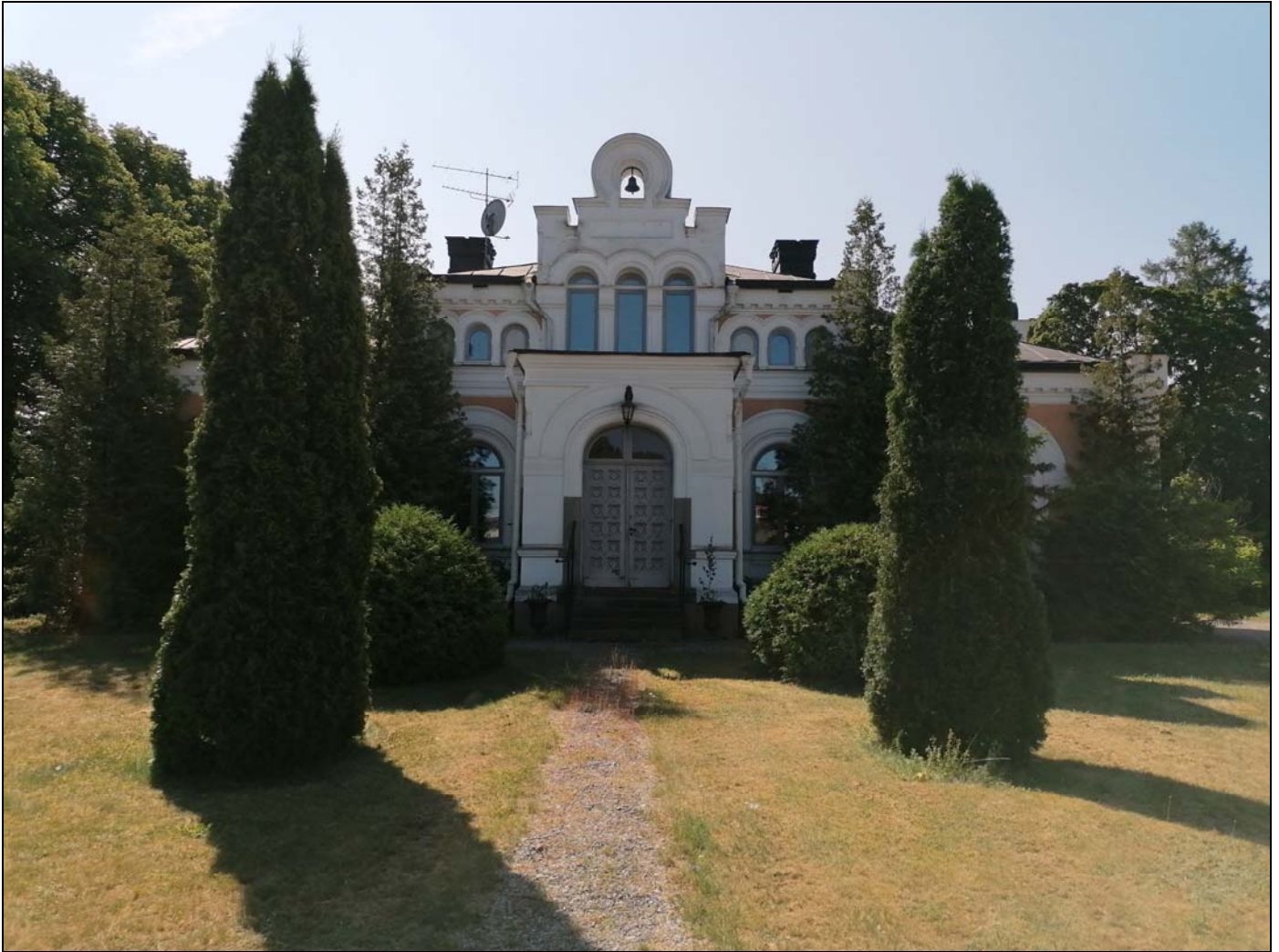
Tingshuset hösten 2021. Växtligheten har klättrat upp för fasaden och skymmer mycket av fönstren. Tingsklockan finns kvar, liksom spikarna där skylten en gång suttit.
