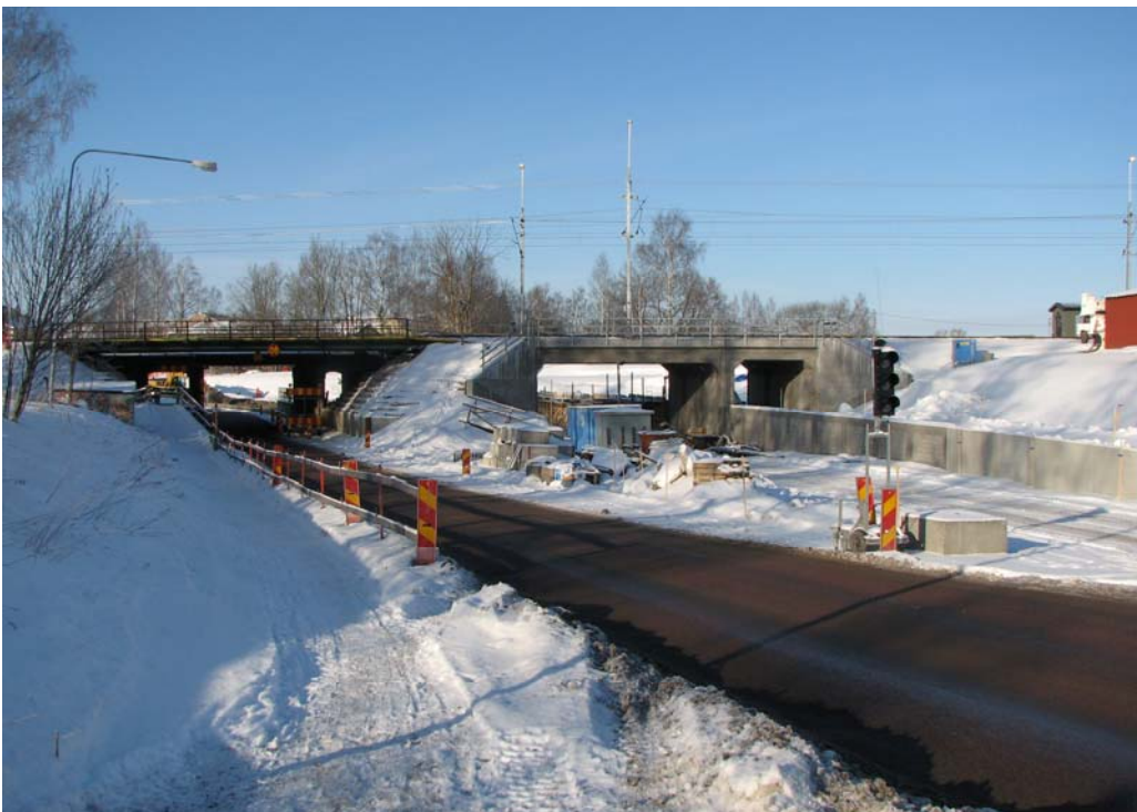
Gamla och nya viadukten.
